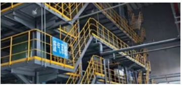
中国建材装备集团助力全球首条用油泥生产高强建筑轻骨料环保示范线
